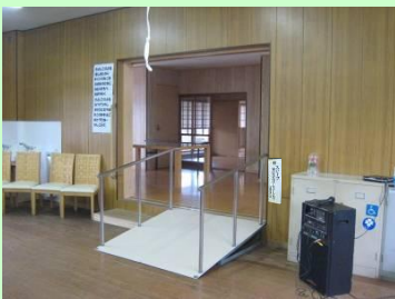
段差解消スロープの設置
