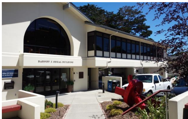
(写真) 学校の図書館
